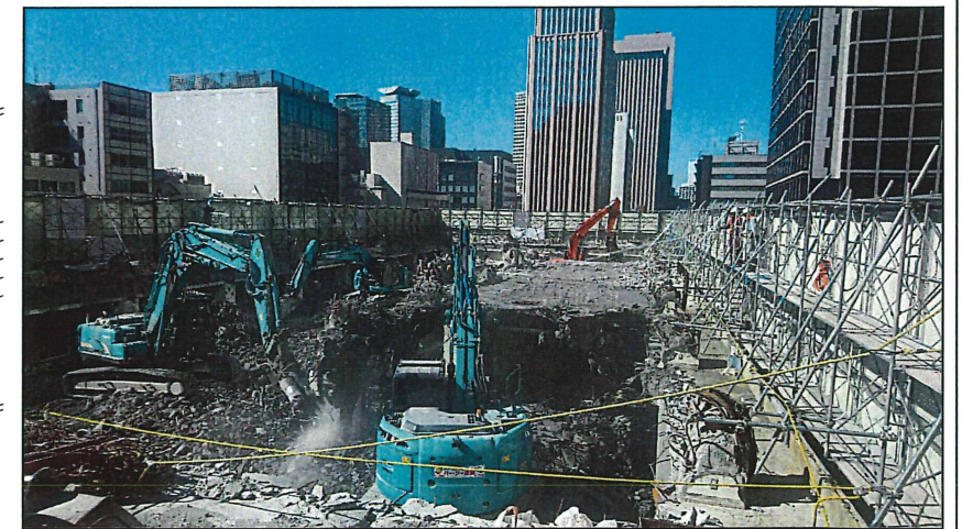
イメージ：建物解体(重機階上解体)
