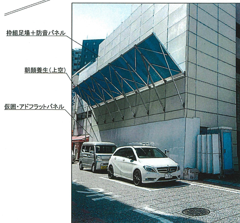
イメージ：朝顔養生、防音パネル、仮囲(アドフラットパネル)
